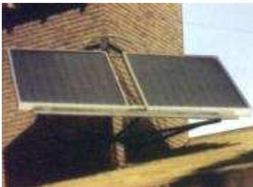
Mediante calentadores se puede transformar la energía del sol en agua caliente de uso sanitario o calefacción. El sistema básico está compuesto por colectores solares más un tanque intermediario aislado.
